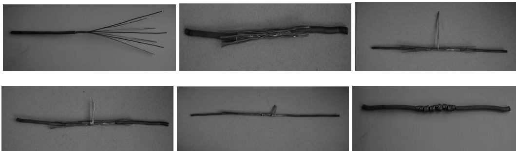
图 1-52 7 股铜芯导线的直接连接
